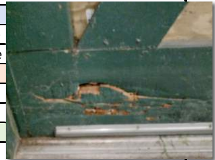
Rotting Door & Window Frames
