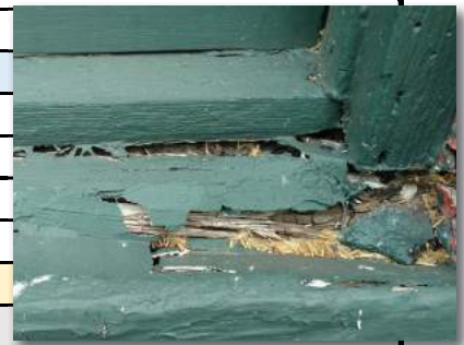
Rotting Door & Window Frames
